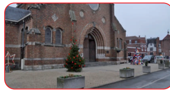
▶ Réhabilitation de la Place Jean Levasseur Coût total : 573 000 €, dont 400 000 € en 2021
