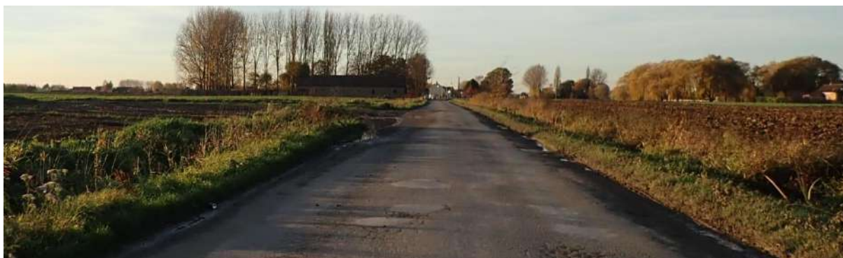
RD22C – sud – L'entrée de ville n'est pas indiquée par un panneau. L'ambiance est agricole avec la présence dominante d'espaces cultivés. Seul le bâti évoque l'approche d'une commune. Malgré une voie en mauvais état, l'entrée est relativement valorisante.
