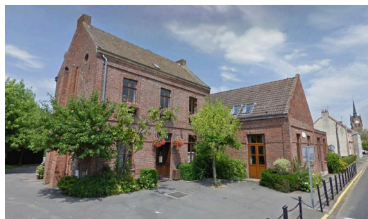
1984 : Réalisation du Centre Socio Culturel
